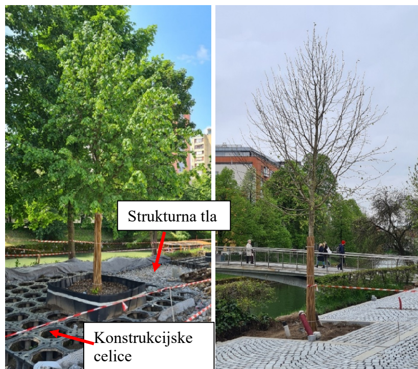
Slika 23: Sadilna jama je obdana s konstrukcijskimi celicami, ki so med seboj povezane s strukturnimi tlemi. Rastni prostor drevesa med gradnjo in po namestitvi tlakov.
