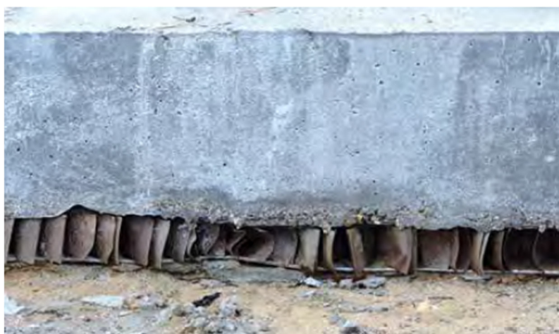
Slika 19: Kadar se plošče za večje konstrukcije ulivajo na mestu, se lahko uporabi biorazgradljiv element za ustvarjanje praznine, ki začasno podpira težo svežega betona, dokler se ta ne strdi. Nato se element navlaži in spere, da ostane praznina, ali pa se pusti, da se naravno razgradi – oboje omogoča kroženje zraka pod ploščo (Vir: Jeremy Barrel Consultancy).
