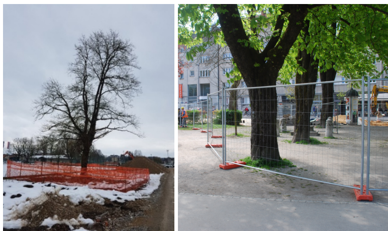
Slika 21: Primeri zaščite območja drevesnih korenin na gradbiščih z neprehodnimi in pritrjenimi ograjami.
