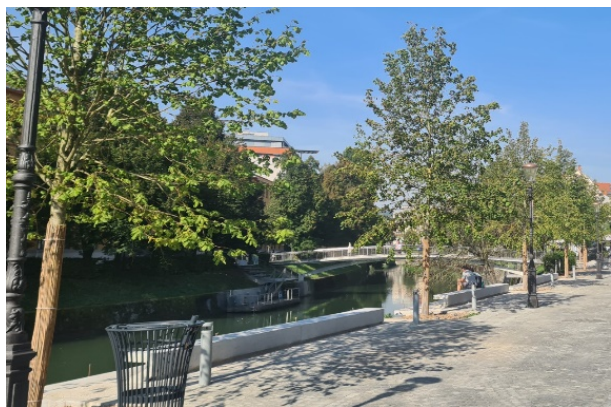
Slika 24: Tlakovano nabrežje po obnovi, tla pod tlakom pa so še vedno zračna in rahla in primerna za rast dreves.
