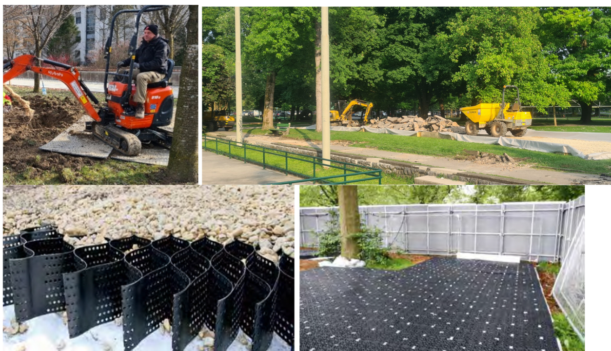
Slika 20: Primeri zaščite tal pred tlačenjem. Levo zgoraj: Povožne plošče prerazporedijo težo stroja, preprečijo tlačenje tal zaradi hoje in s tem varujejo območje drevesnih korenin. Desno zgoraj: Začasno nasutje materiala s ciljem razporeditve teže strojev. Levo spodaj: Geocelice napolnjene s spranim lomljencem. Desno spodaj: Primer začasne zaščite tal z ArborRaft sistemom, kjer polnjenje z lomljencem ni potrebno (Vir slik spodaj: Barrell Tree Consultancy, 2020).
