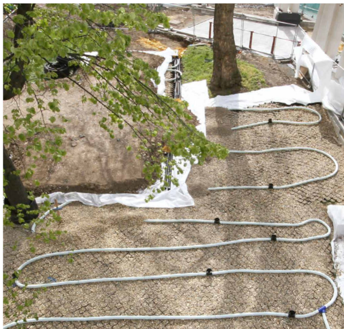
Slika 18: Geocelice napolnjene z lomljencem z zračnim sistemom (Vir: Barrell Tree Consultancy, 2020).
